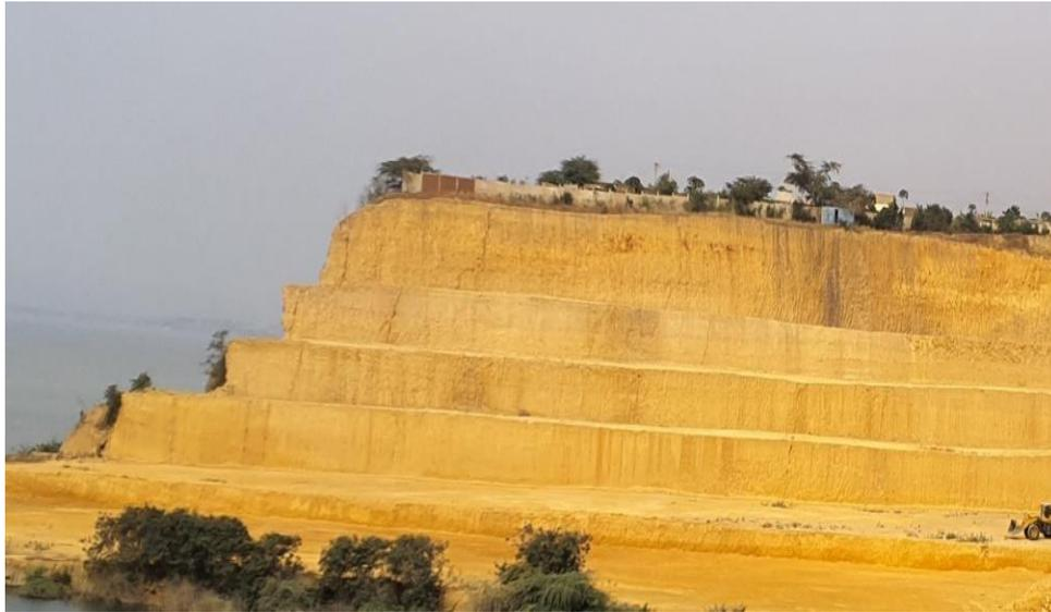
**Figura 7:** Método de exploração em bancadas da NC1
